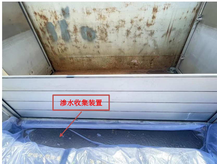
B7.漏水收集装置
